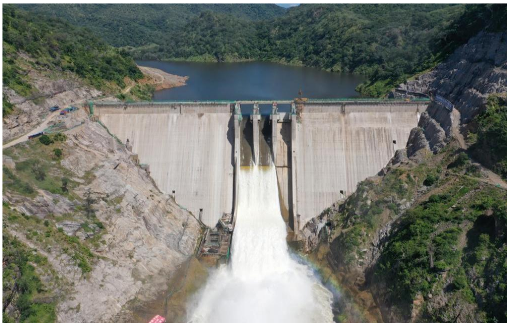
下凯富峡水电站大坝
